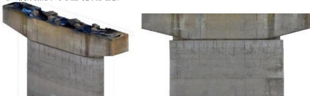
ドローンで取得した画像から3Dモデルを生成、橋梁状態を網羅的に把握可能か検証。
